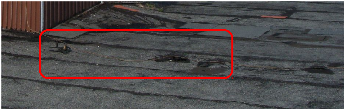
Fot. 7. Mocowanie instalacji odgromowej.
