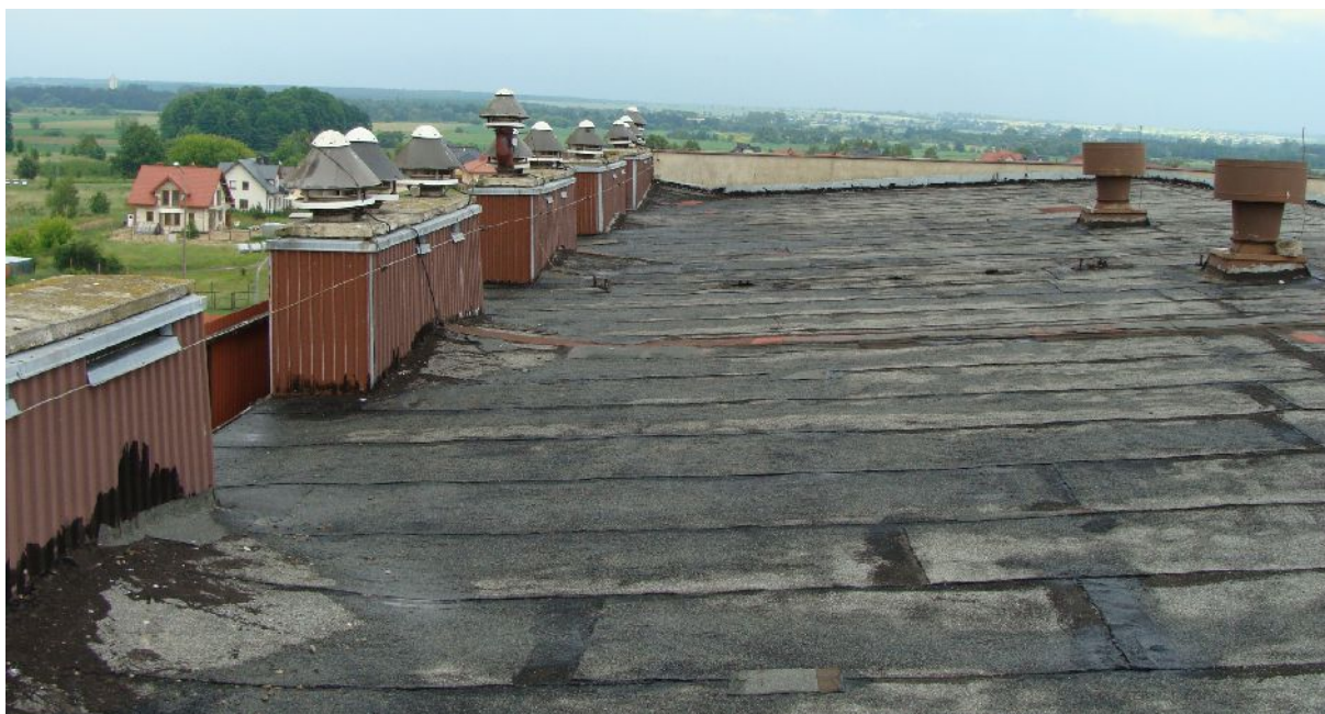
Fot. 2. Widok na dach z usytuowaniem kominów wentylacji.
