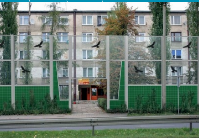
Ekran akustyczny z elementami przerw przed zabudową wielorodzinną.
