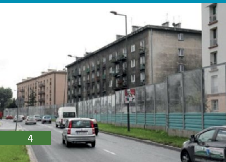
Ekran akustyczny betonowo - przezroczysty.
